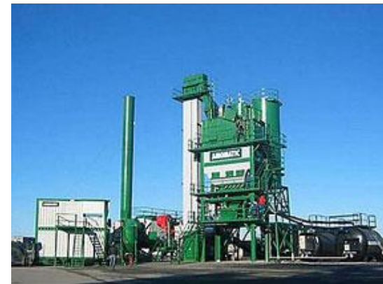
Асфальтобетонный завод Амоматик
